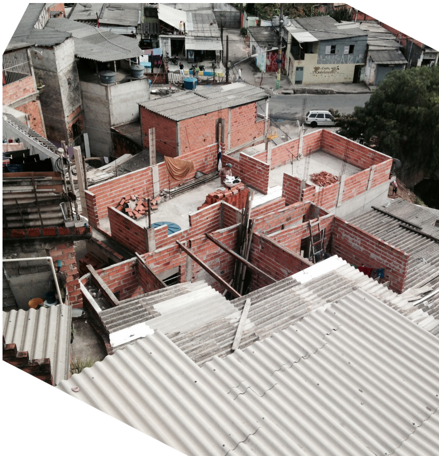
Figure 1. A typical autoconstrução site in Parada de Taipas, São Paulo.
